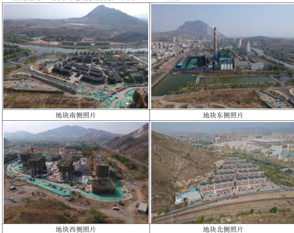
图 4.2-5 项目相邻地块现状照片
