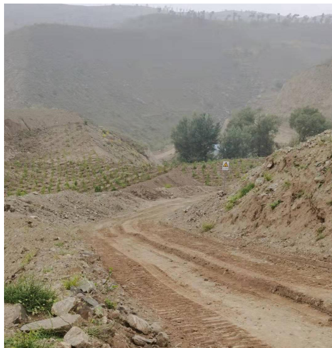
矿区道路硬化
