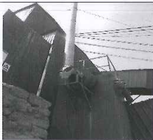
机制砂生产线破碎、筛分废气布袋除尘器+15 米高排气筒
