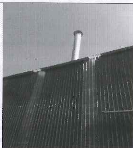
机制砂生产线破碎、筛分废气布袋除尘器+15 米高排气筒
