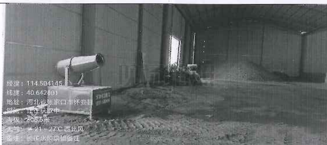
成品库房全封闭并设置雾炮抑尘
