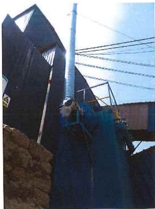
机制砂生产线破碎、筛分废气布袋除尘器+15 米高排气筒 (1#)
