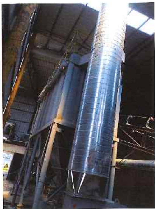
机制砂生产线破碎、筛分废气布袋除尘器+15 米高排气筒 (1#)
