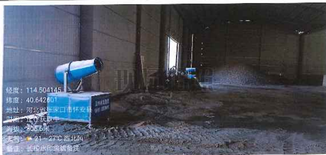
成品库房全封闭并设置雾炮抑尘
