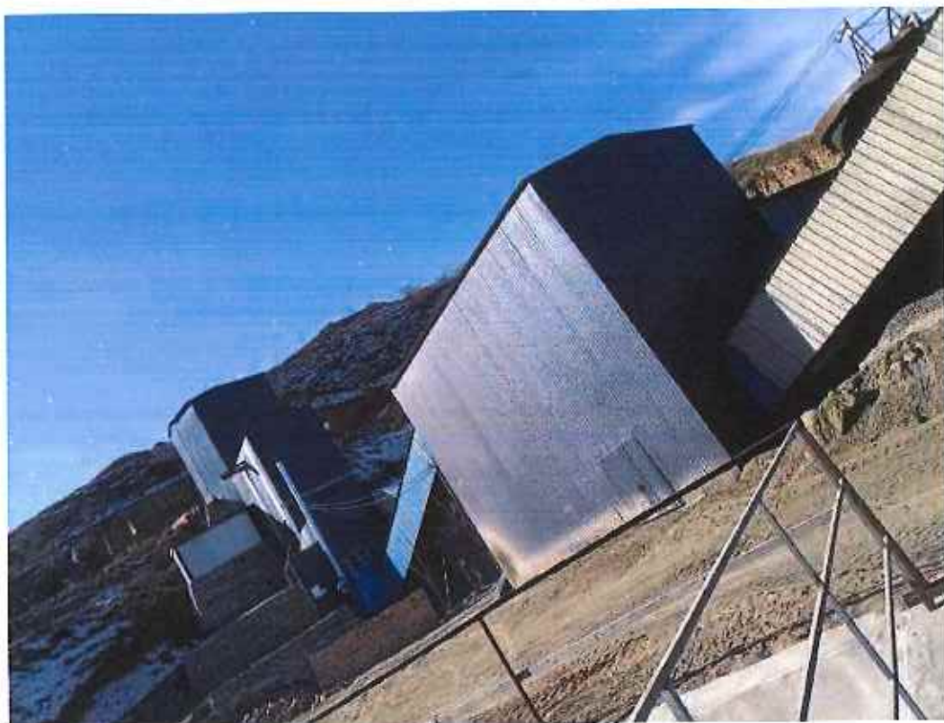
车间、输送廊道全封闭
