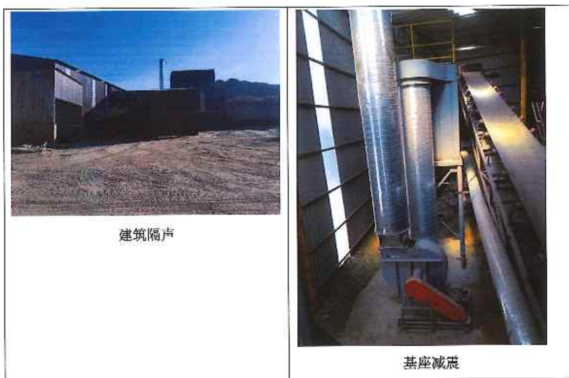
图 3-3 噪声防治设施现场照片
