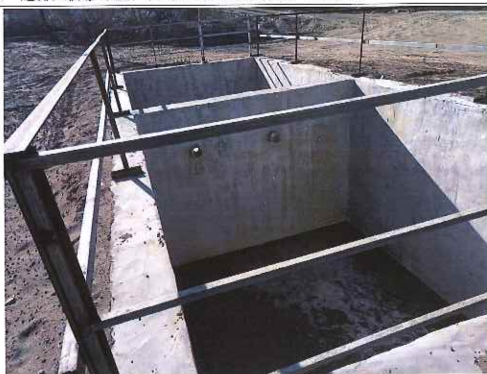
沉淀池现场照片
