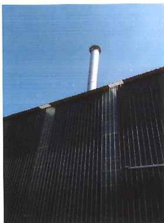
机制砂生产线破碎、筛分废气布袋除尘器+15 米高排气筒 (1#)
